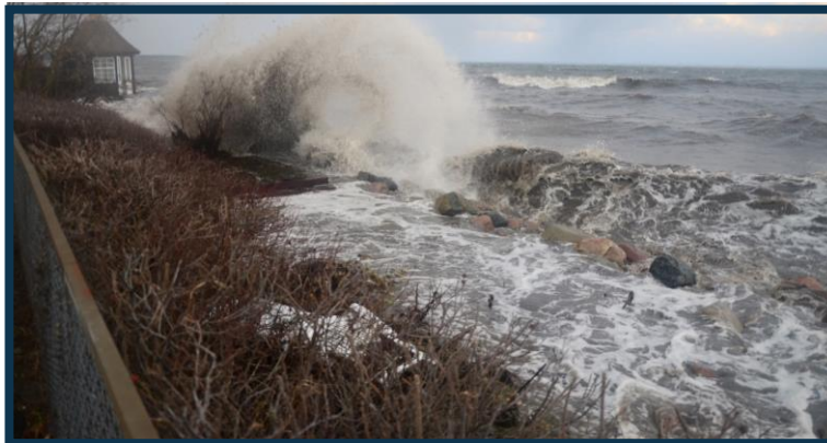
En klimasikring, der sikrer, at havnen kan modstå stormfloder og havvandsstigninger i de næste 50 år
