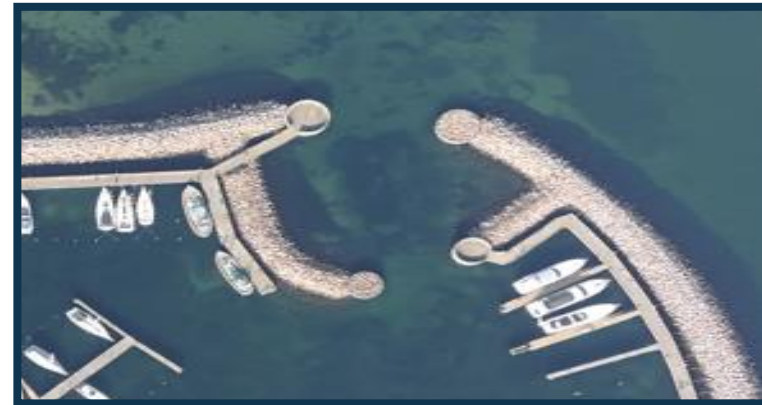
En moleopbygning, der understøtter sikkerheden for sejlerne i indsejlingen og gæstehavnen
